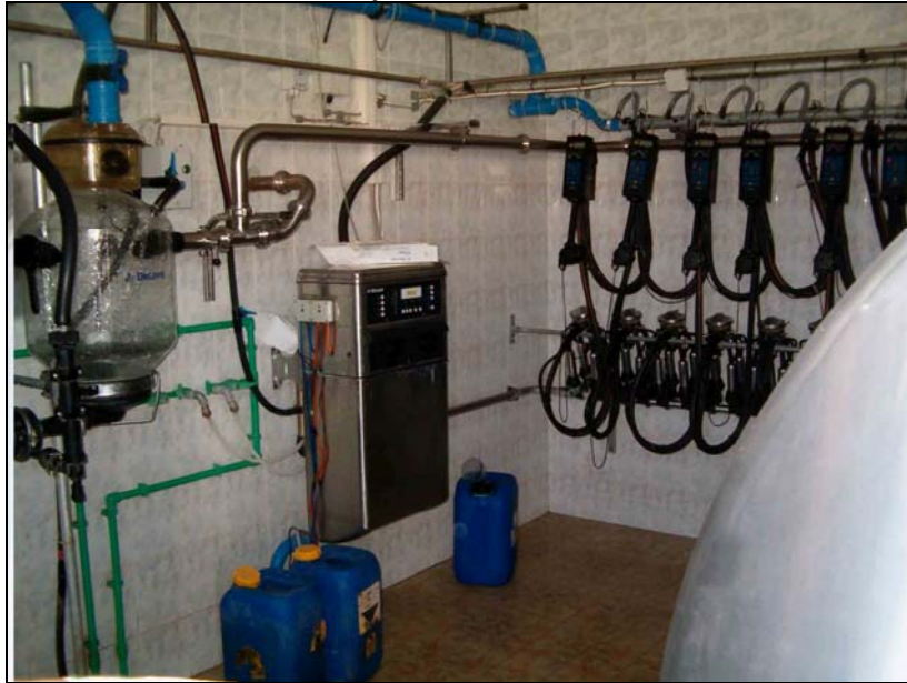
Sl. 3. Centralno postrojenje sa opremom za pranje i dezinfekciju, i cisterna za mleko.
